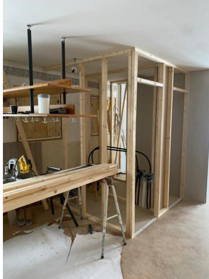
Vy över hallen och de nya toaletterna. 2024-01-13 Foto: CPJ
