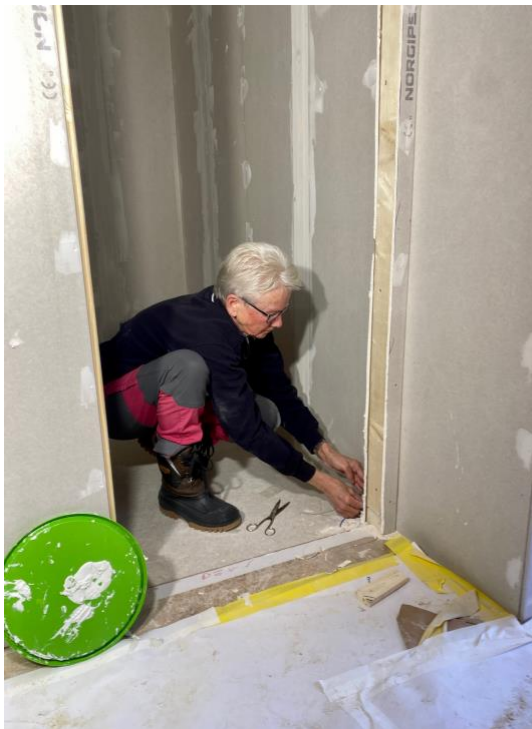
Gunilla Pedersson fäster remsa i skarvarna för att sedan gå på med spackel. 2024-01-25 Foto: CPJ
