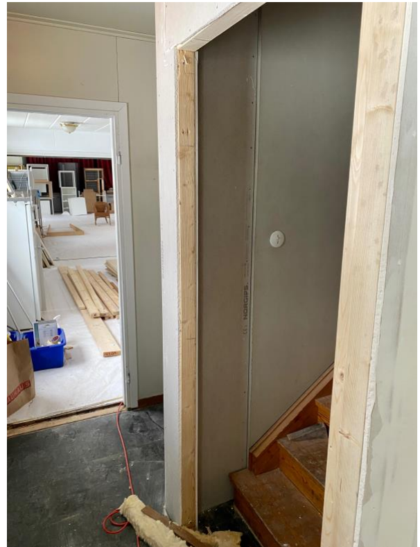
För att slippa kallras sätts en dörr för källartrappan. 2024-01-25 Foto: CPJ
