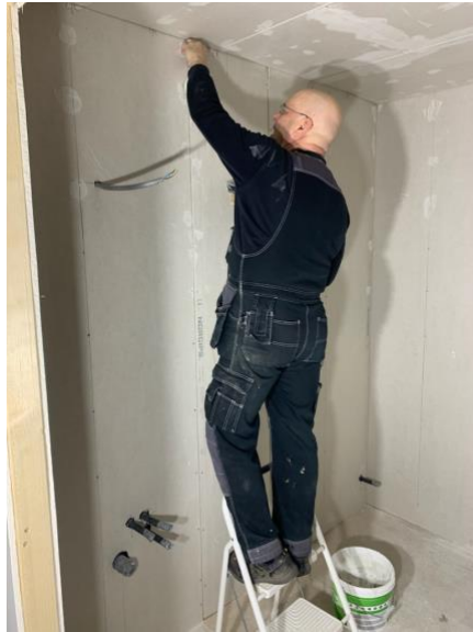
Per Elander utövar kvällsarbete på toaletterna 2024-01-22 Foto: Tommy Johansson
