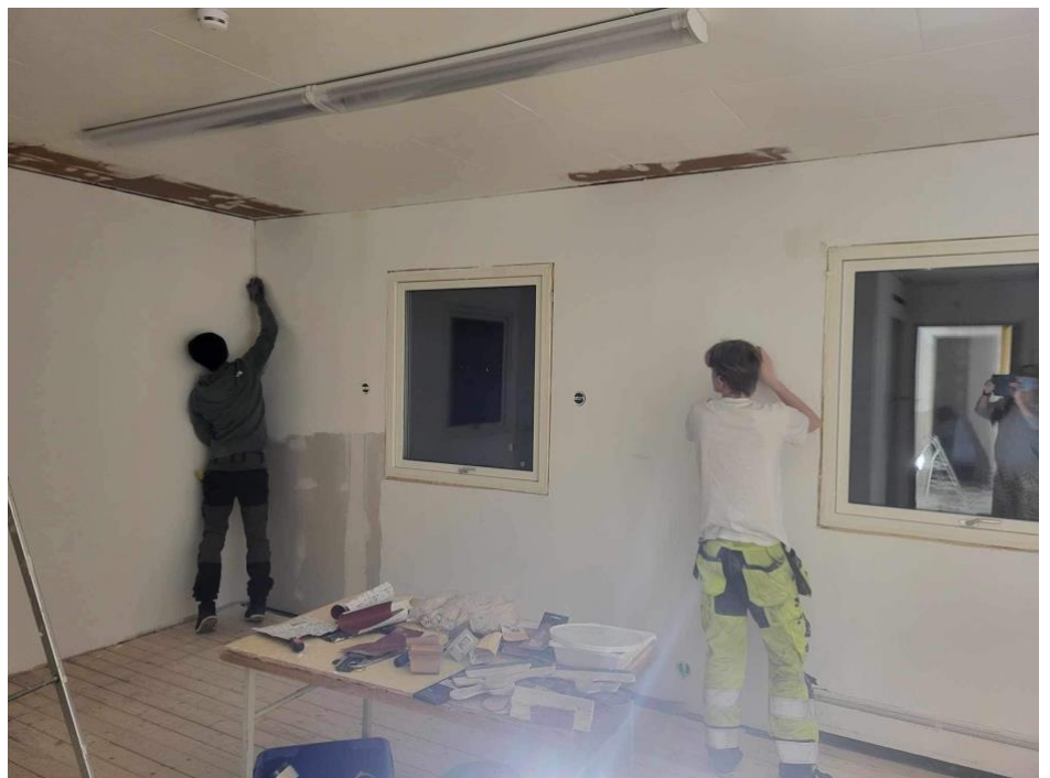
Bröderna Simon och Linus Andersson kommer till bygdegården på tisdagskvällen och hjälper till att slipa och spackla köket. 2024-01-30. Foto: Maria Stolt
