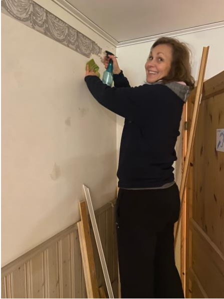
Kvällsarbete för Camilla Morgan med att ta bort bården i foajén.. 2024-02-05 Foto: CPJ
