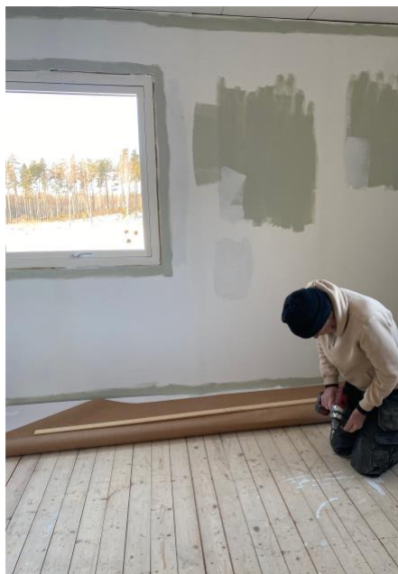
I köket jobbar Jan-olov Johansson med att göra trägolvet stadigt. 2024-02-05 Foto: CPJ
