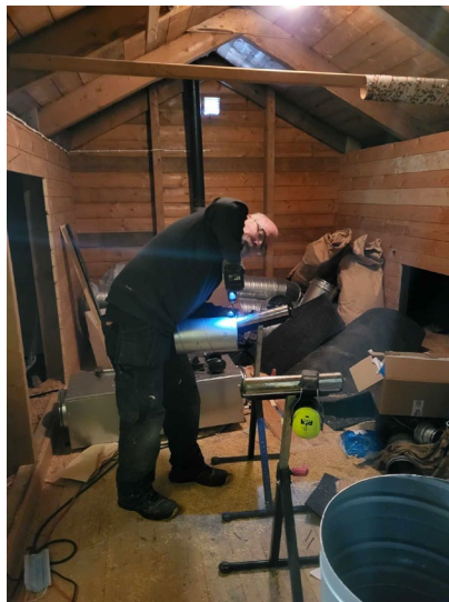
Olle i full färd med montering av ventilation på vinden. 2024-02-18 Foto: Maria S
