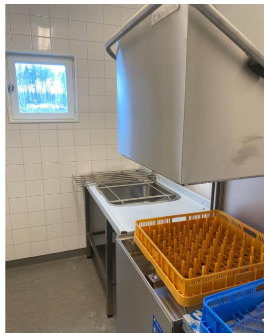
Diskmaskinen har monterats in. 2024-03-25 Foto CPJ
